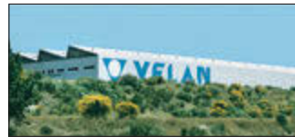
Lisbon, Portugal Velan Válvulas Industriais, Lda.
