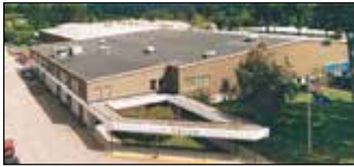
Williston, États-Unis Velan Valve Corp., Usine 3
