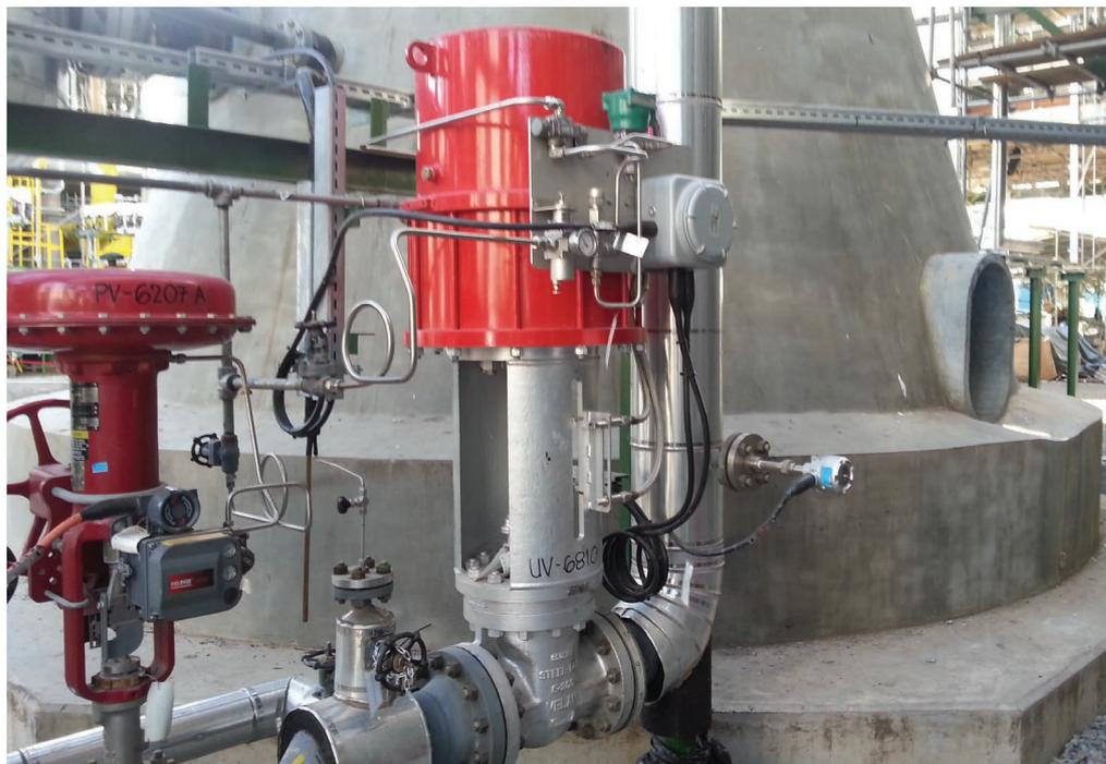
Un robinet-vanne à commande pneumatique de 6 po et de classe 300, installé dans l'unité de craquage de naphte.
