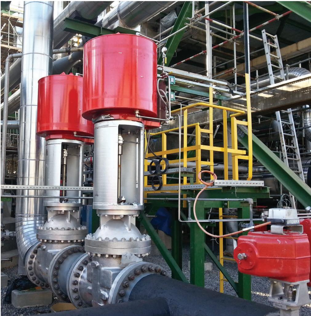
Deux robinets-vannes à commande pneumatique de 18 po et de classe 300, installés dans l'unité de craquage de naphte.
