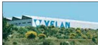
Lisbon, Portugal Velan Válvulas Industriais, Lda.
